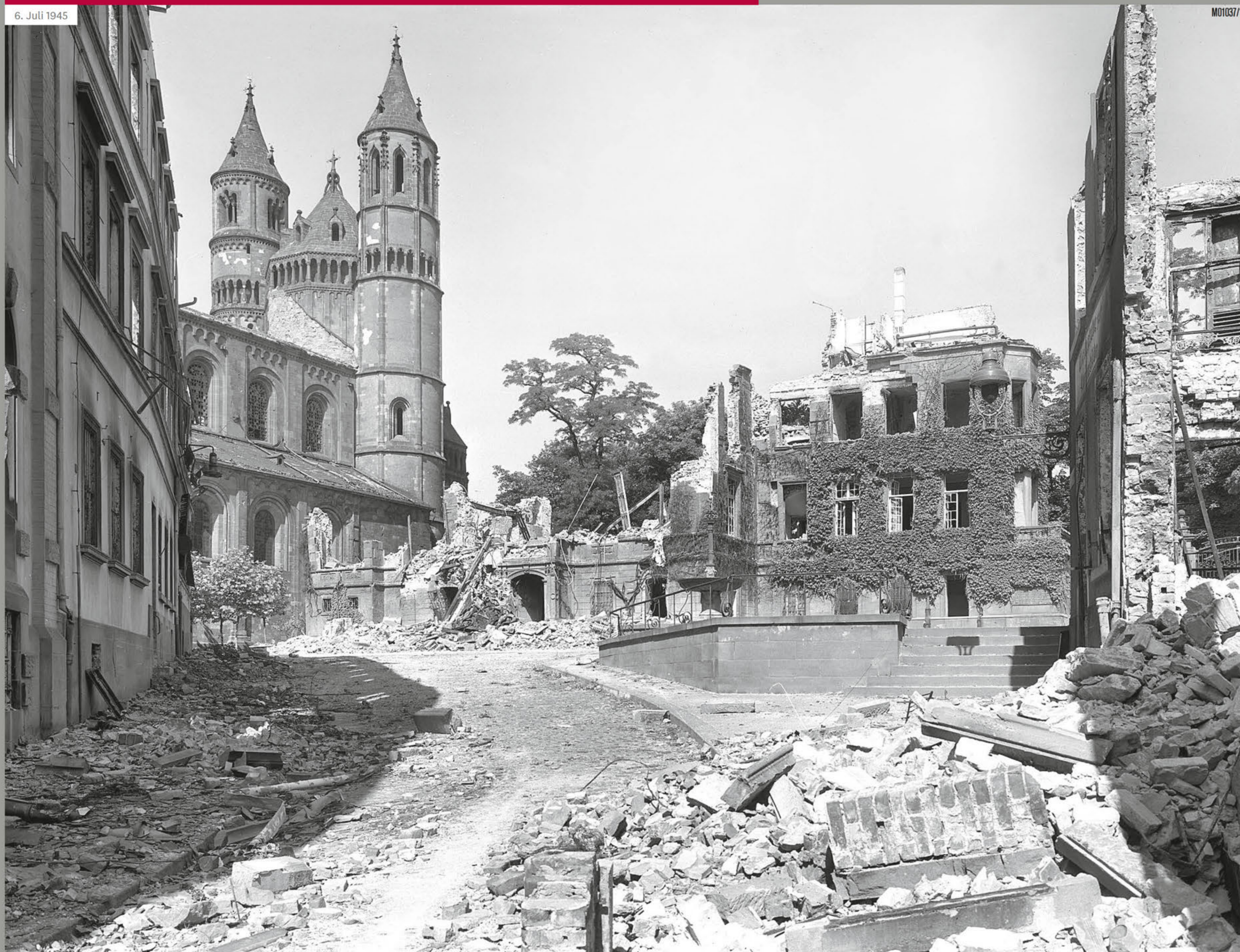
Blick aus der Hofgasse nach Südwesten auf die Nordseite des beschädigten Doms und die Reste des schwer getroffenen Heyl'schen Schloßchens
