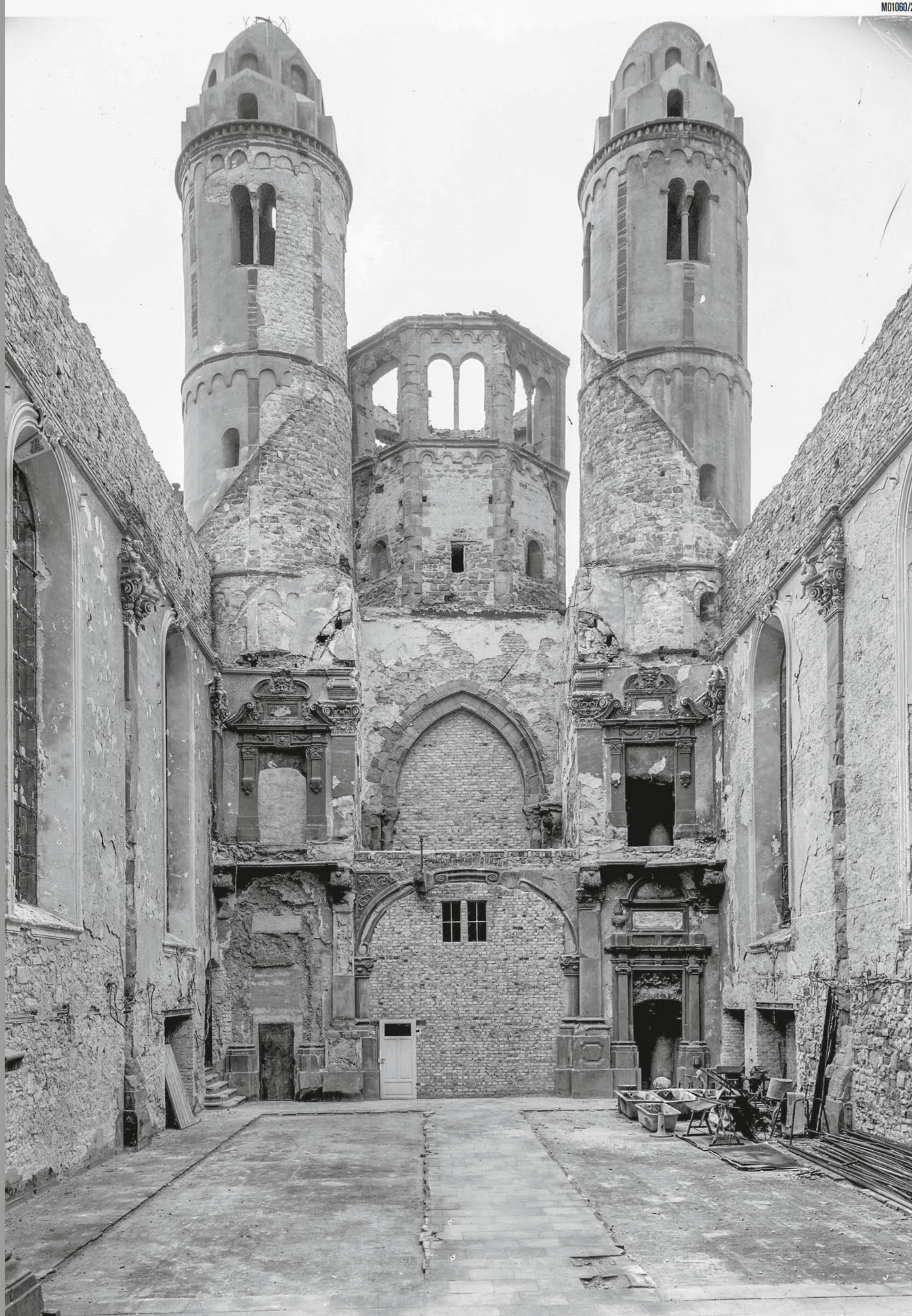
M01060/2 Zerstörter Ostchor der Pauluskirche: Blick auf den Altar nach Osten; das Mittelschiff ist ohne Dach
