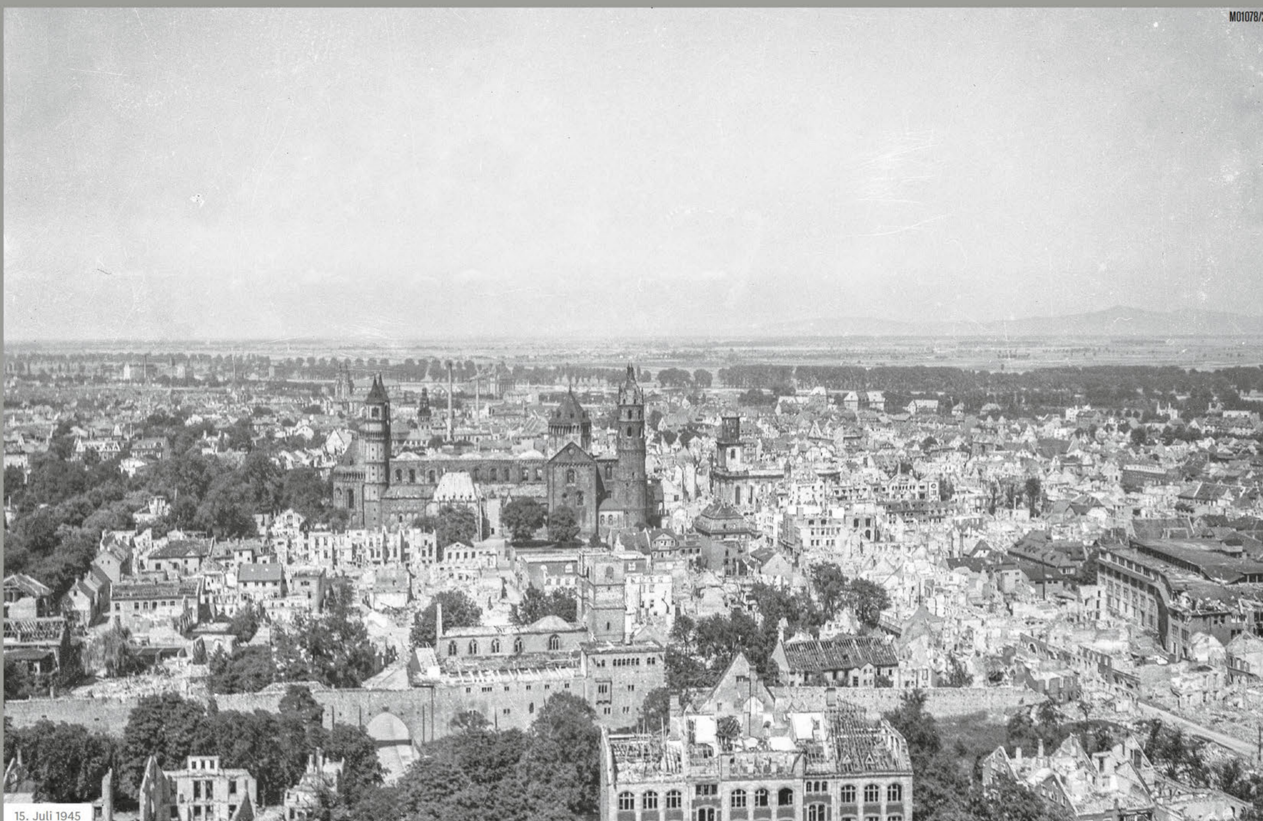
Foto der Innenstadt von Süden: Ganz unten die schwer beschädigte Neusatzschule (Volksschule), darüber das ebenfalls stark getroffene Andreasstift und der abgedeckte Dom. Extrem sind die Zerstörungen entlang der Valkenbergstraße (rechte Bildhälfte) bis zum Marktplatz mit der Ruine der Dreifaltigkeitskirche
