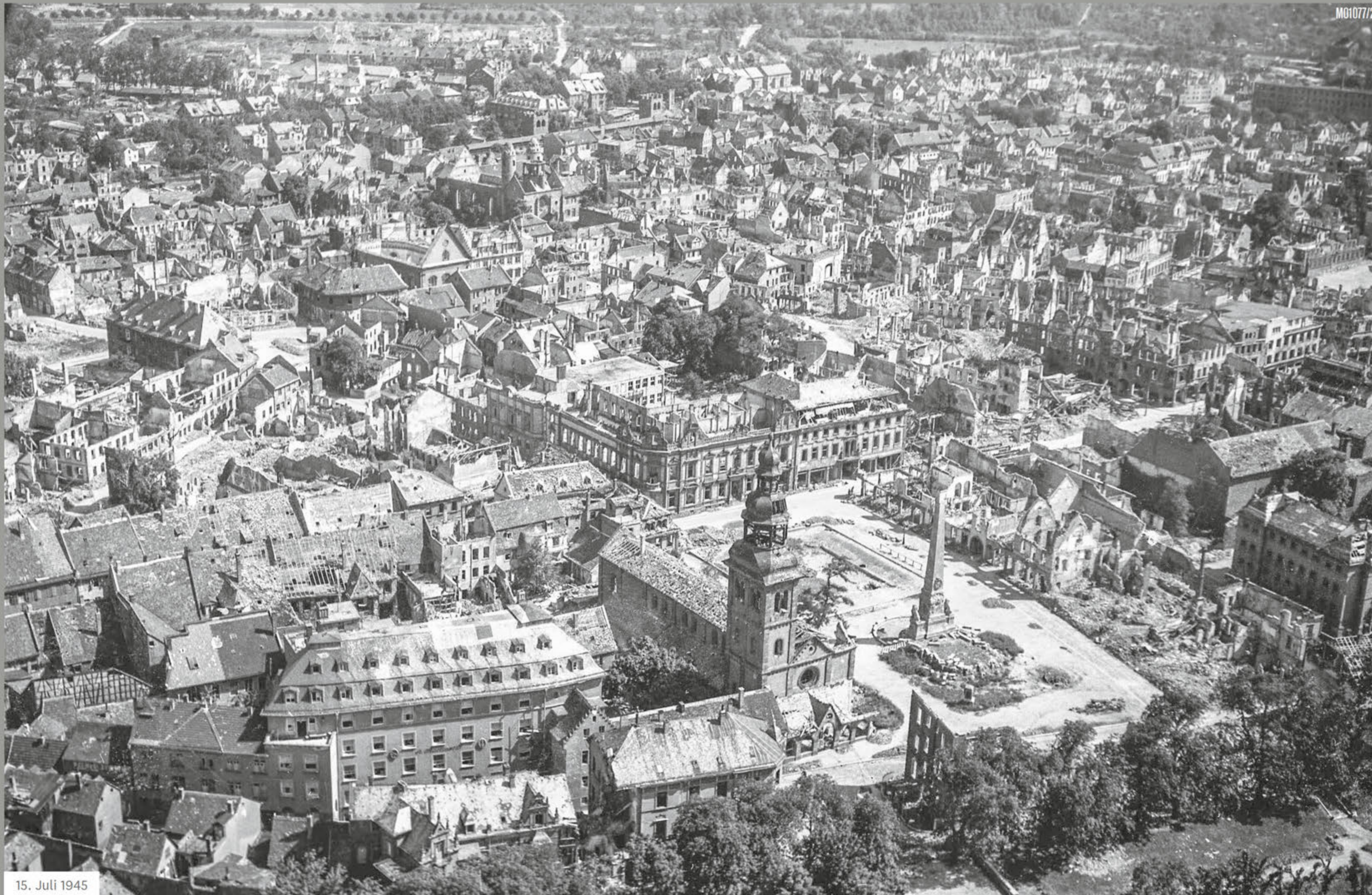
Das Gebiet um den stark getroffenen Ludwigsplatz von Westen mit der massiv beschädigten Martinskirche, in der unterem Bildmitte das nicht mehr aufgebaute Hauptpostgebäude.
