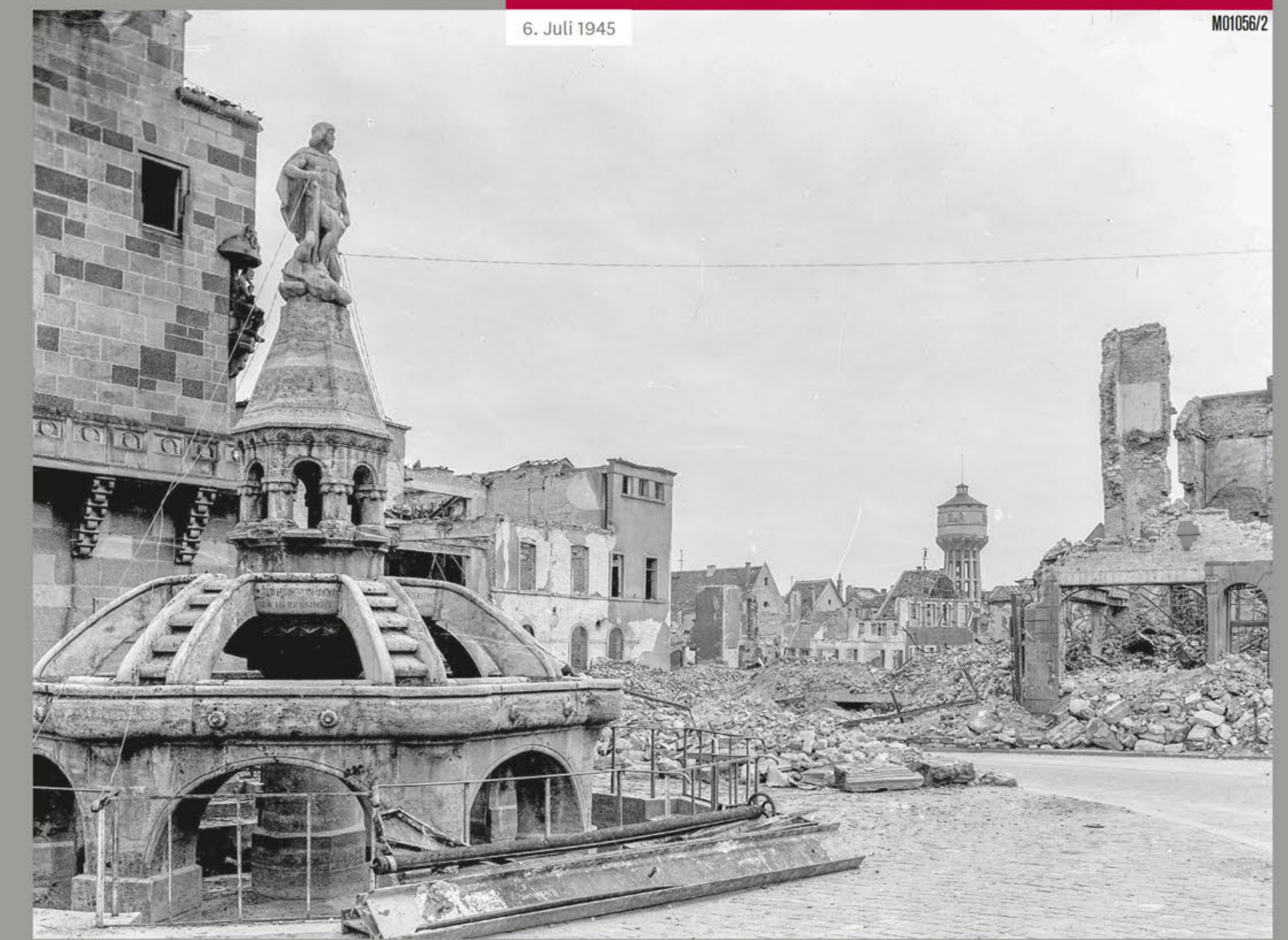
Siegfriedbrunnen auf dem Markt- platz; Blick nach Südosten auf die zerstörten Häuser des Neumarkts, im Hintergrund der Wasserturm der Lederwerke Doerr & Reinhart
