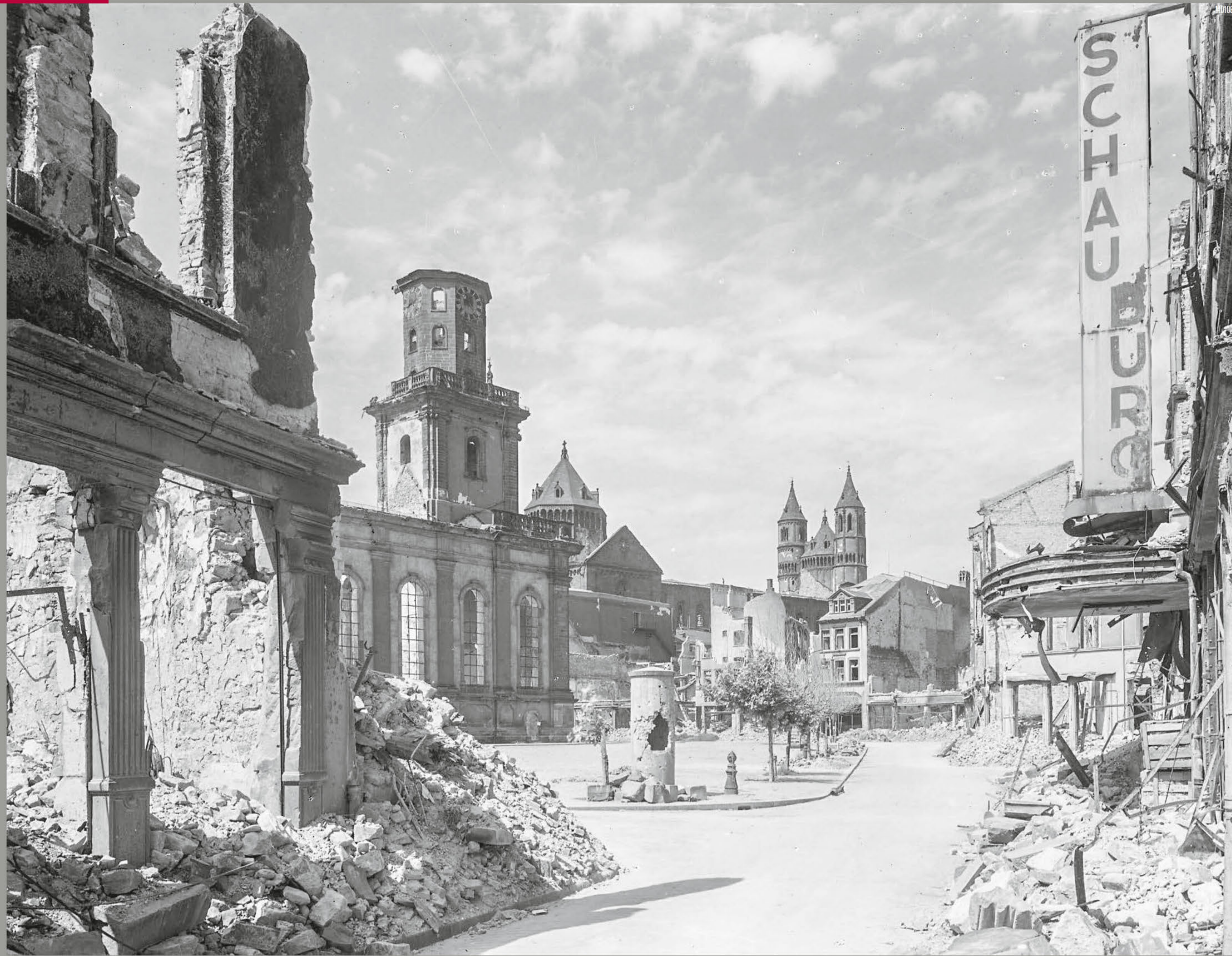
Blick von der Petersstraße auf den zerstörten Markt- platz und die Ruine der Dreifaltigkeitskirche, rechts die Trümmer der Schauburg-Lichtspiele, im Hintergrund der Dom
