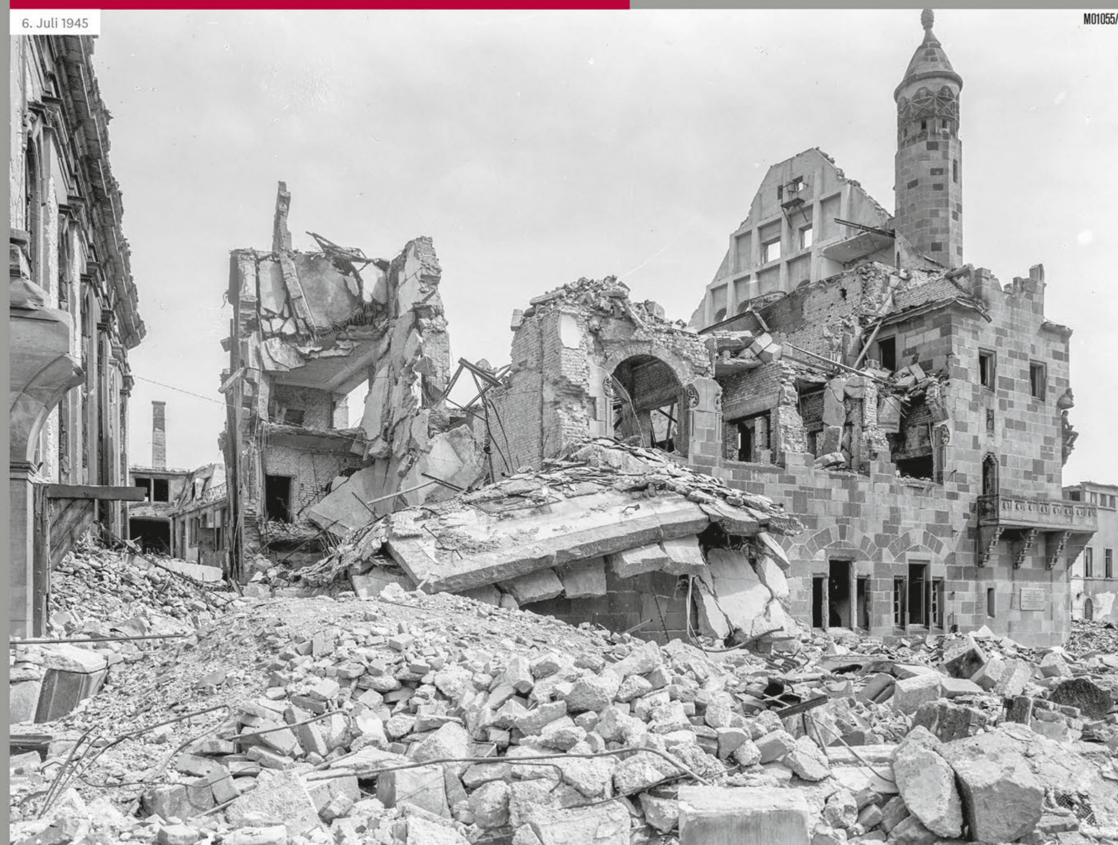
Blick vom Markt- platz auf die Trümmer des Cornelianums; am linken Bildrand die ebenfalls stark beschädigte Drei- faltigkeitskirche
