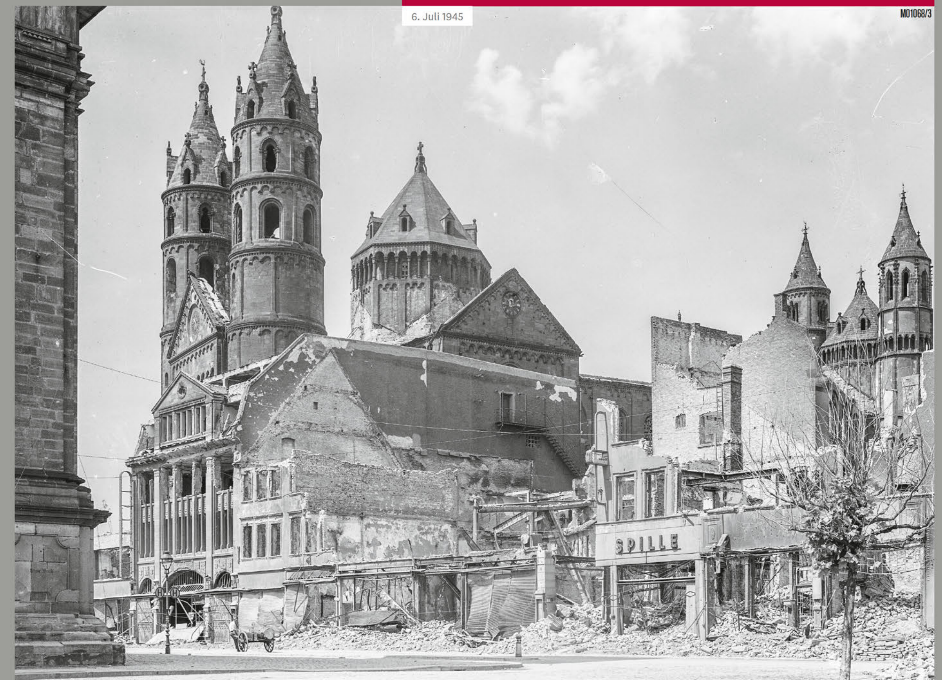
Marktplatz, zerstörte Häuser vor dem schwer beschädigten Dom
